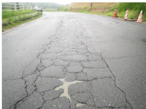
■ 農道上下堤・竹谷線の舗装破損状況
