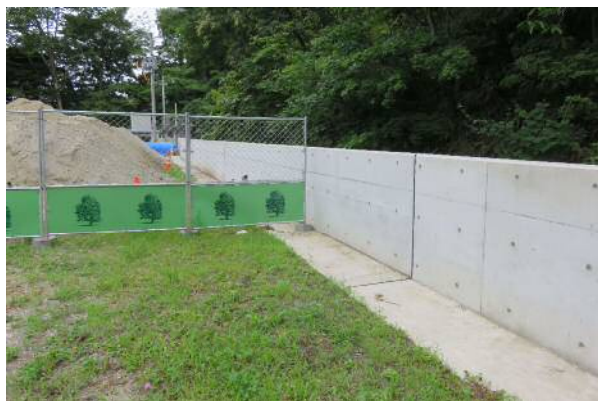
■施工中の小石浜排水区 護岸工事 (復興交付金事業)
