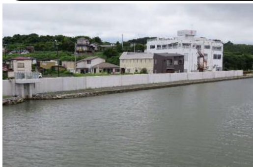
■高城川護岸工事（国道45号側）
