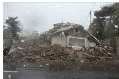
倒壊した家屋（高城）
