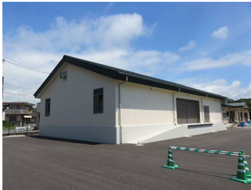
■完成した備蓄倉庫（本郷ふれあいセンター隣接地）
