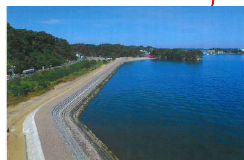
■完成した浪打浜防潮堤
