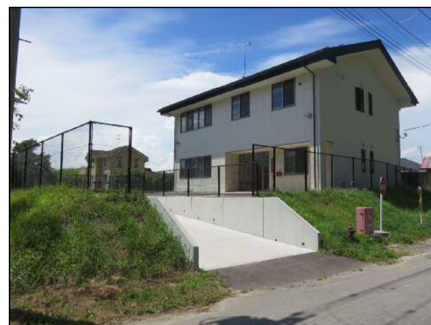
■完成した手樽地区復興まちづくり拠点施設
