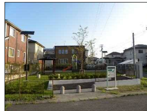
■完成した防災広場
