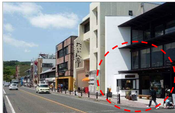
【現況】 歩道幅員2.5m
