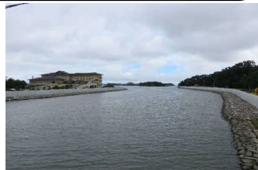
■高城川護岸工事（松島大橋付近 右側）
