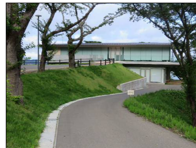
■完成した復興まちづくり支援施設
