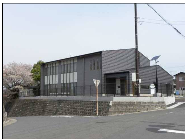
■完成した白萩地区避難所
