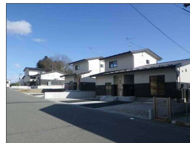
■完成した災害公営住宅（美映の丘地区）
