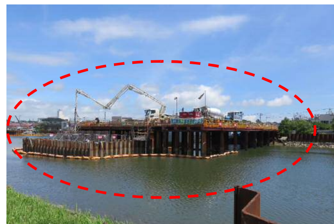
■整備が進む新松島橋
