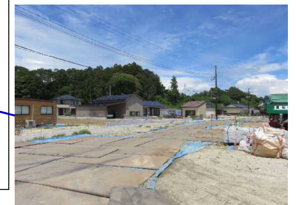
■嵩上げ工事が進む名籠地区
