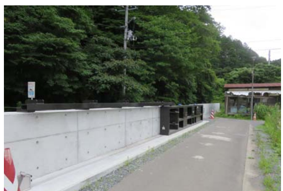
■小石浜排水区 護岸工事（復興交付金事業）
