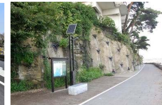
■完成後の法面
