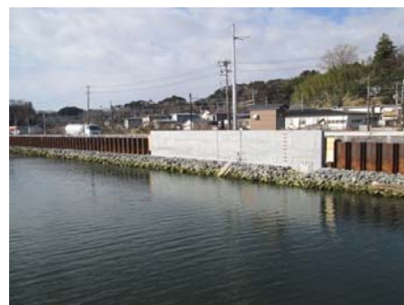
■高城川護岸整備（国道45号側）
