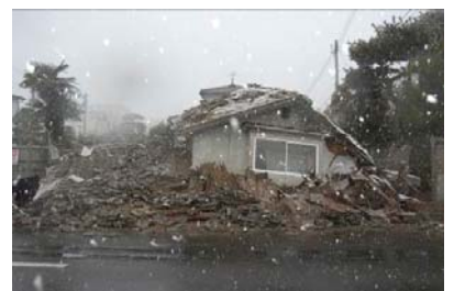
倒壊した家屋（高城）
