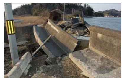
津波で崩壊した堤防（手樽）
