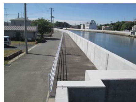
■高城川護岸整備（旧役場側）
