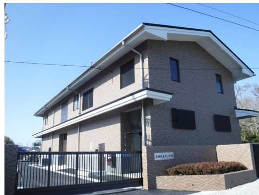
■長田雨水ポンプ場建設工事（復興交付金事業）
