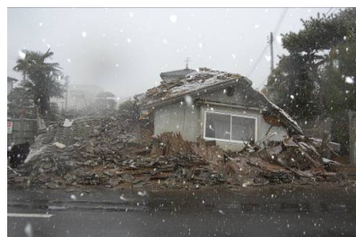
倒壊した家屋（高城）
