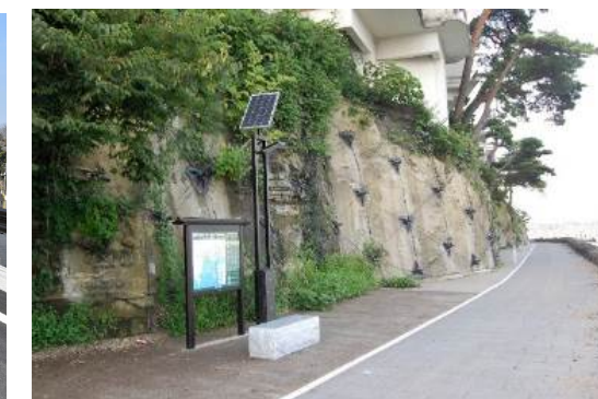
■完成後の法面
