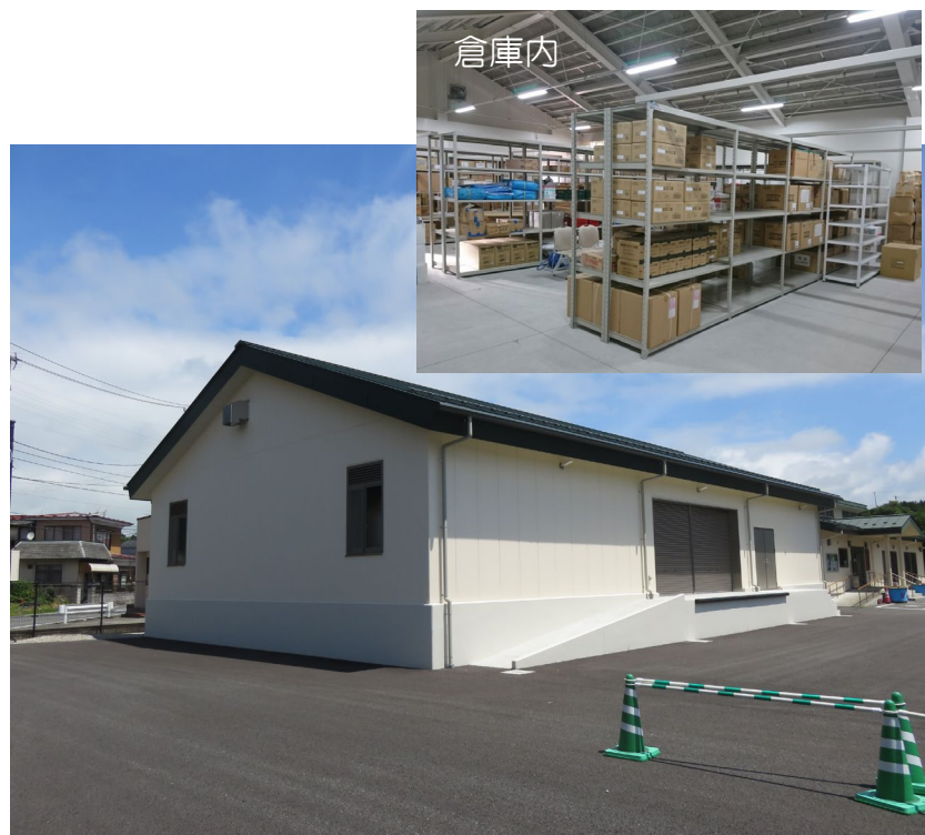
■備蓄倉庫（本郷ふれあいセンター隣接地）
