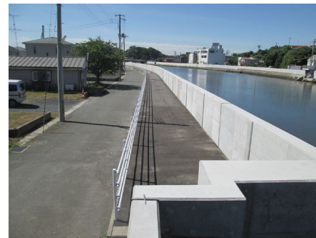
■高城川護岸整備（旧役場側）
