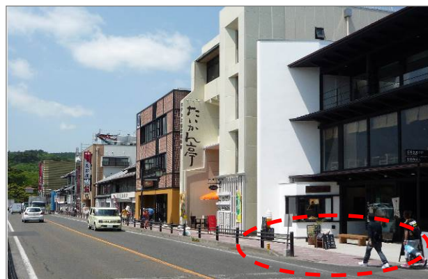
【拡幅前】 歩道幅員2.5m
