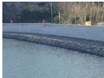
■高城川護岸整備（国道45号側）
