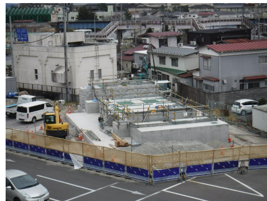
■小梨屋雨水ポンプ場建設工事（復興交付金事業）
