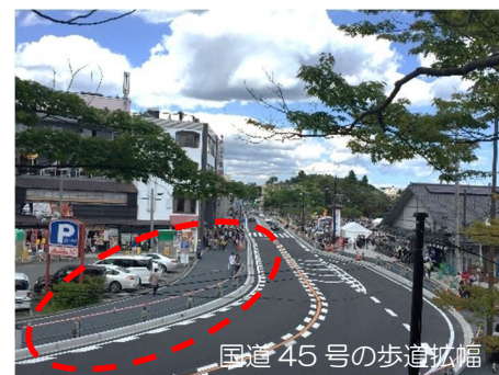
【拡幅後】歩道幅員 4.5m
