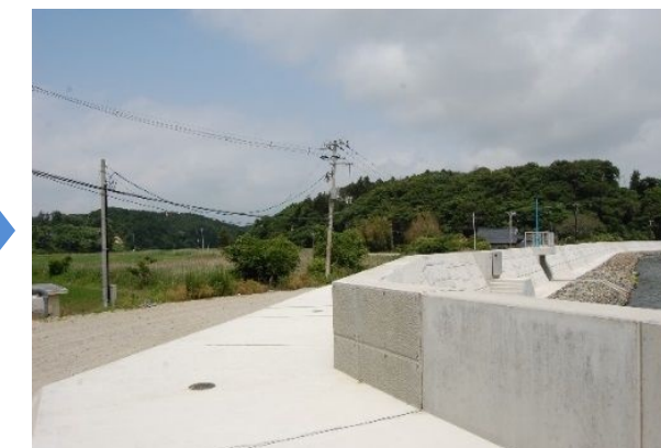
◆堤防(手樽):崩壊した農地海岸堤防の復旧が完了しました。
