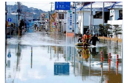
津波で冠水した国道45号(松島)
