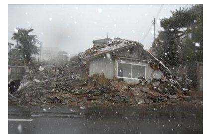
倒壊した家屋(高城)
