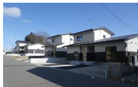
災害公営住宅（美映の丘地区）
