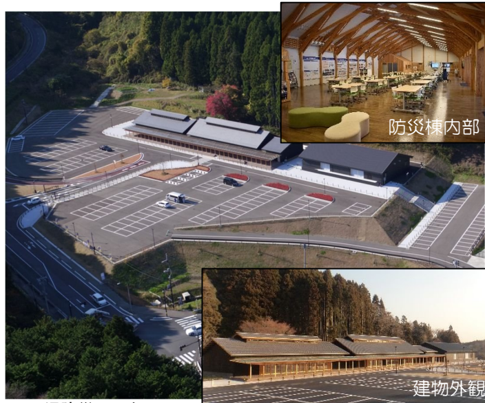
石田沢防災センター
