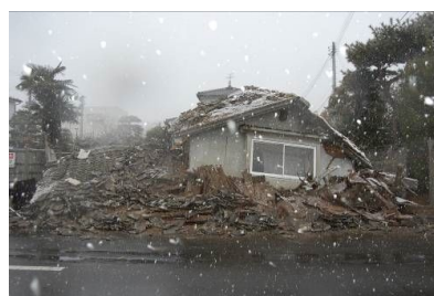
倒壊した家屋（高城）
