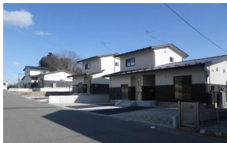
災害公営住宅（美映の丘地区）
