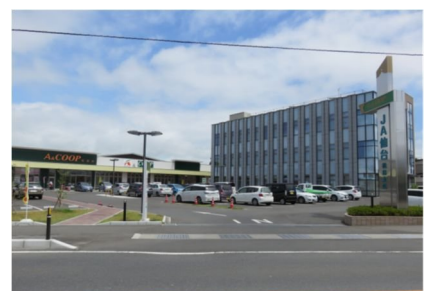
高城地区津波避難施設（2階一部・3階）
