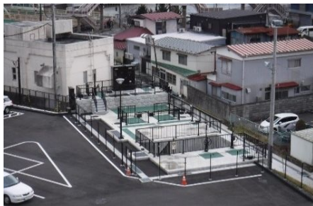
小梨屋雨水ポンプ場
