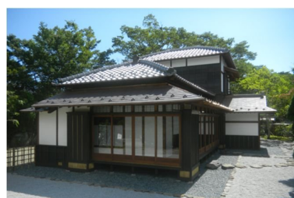
松島海岸公園避難施設
