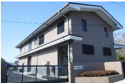
長田雨水ポンプ場
