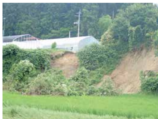
▲崖崩れ（桜渡戸地区）
