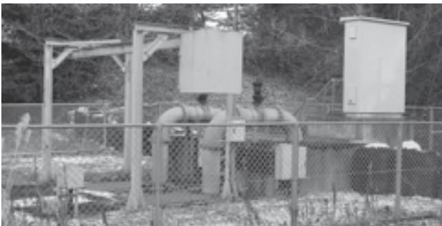
▲新たにポンプを設置します
