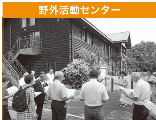
維持管理状況の確認
