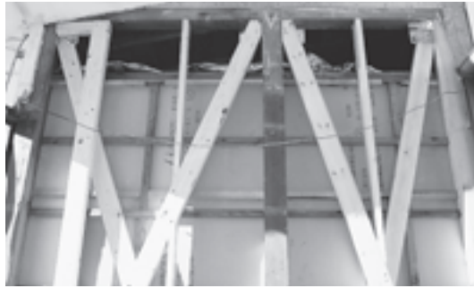
一般住宅耐震補強工事
