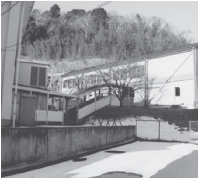
手樽地域交流センター体育館
