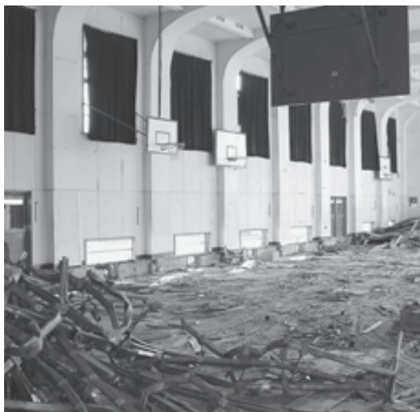
解体中の松島中学校講堂
