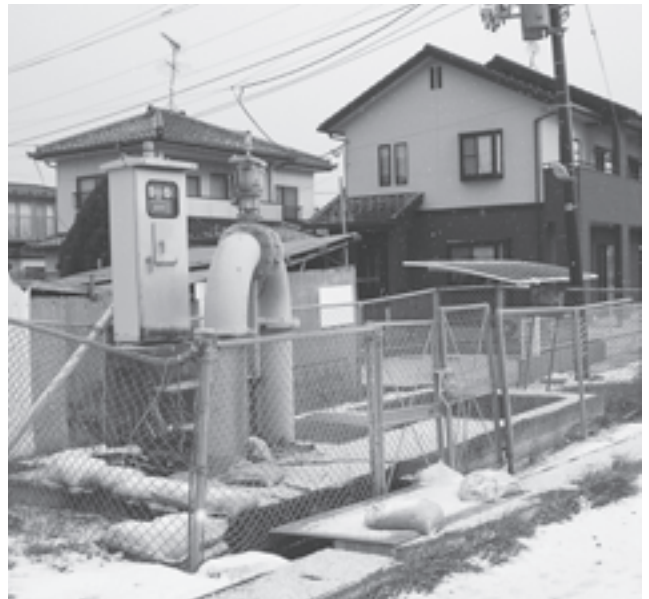
長田第2排水機場
