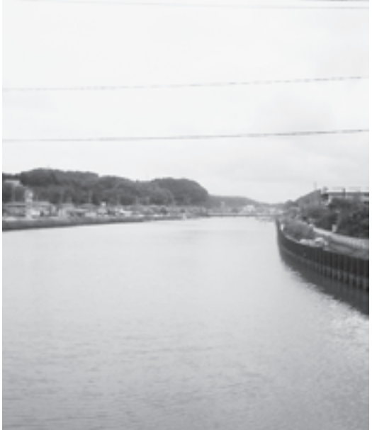
改修中の高城川
