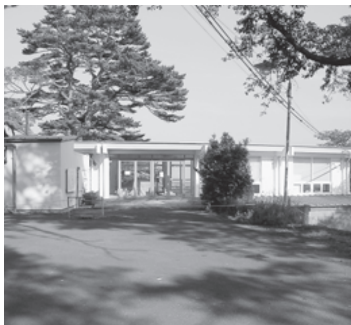
建替される松島パノラマハウス
