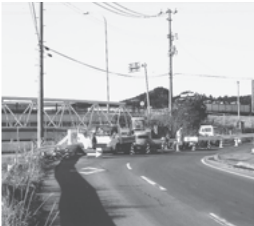
下水道修復工事
