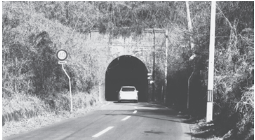
根廻トンネル
