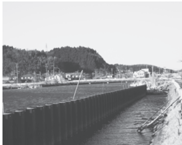
高城川の堤防改修工事（中橋付近）
