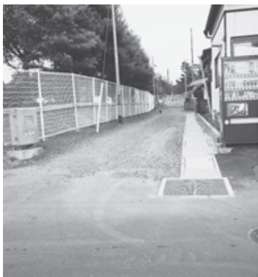
迎山地区雨水路整備工事
