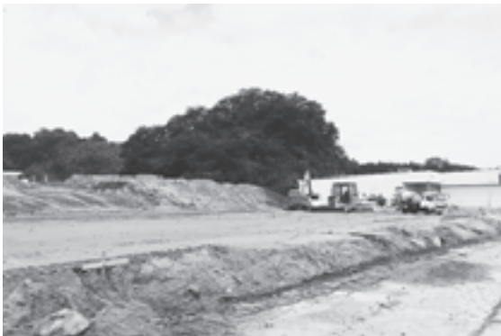
かさ上げ工事
