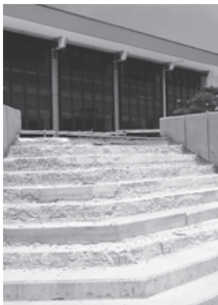
改修中の中央公民館
