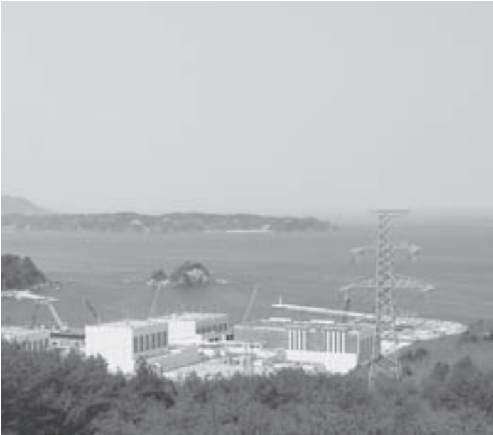
女川原子力発電所 (東北電力提供)
