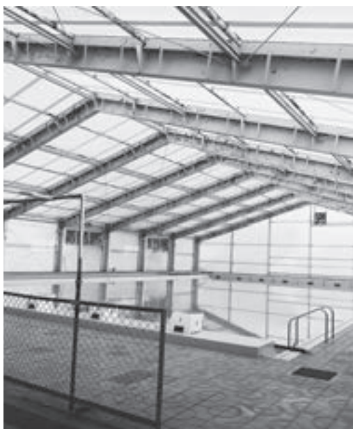
松島中学校プール
