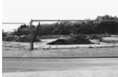
人工芝張り替え工事（松島運動公園）
