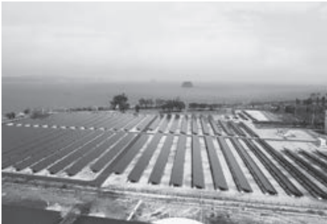
仙台太陽光発電所パネル
