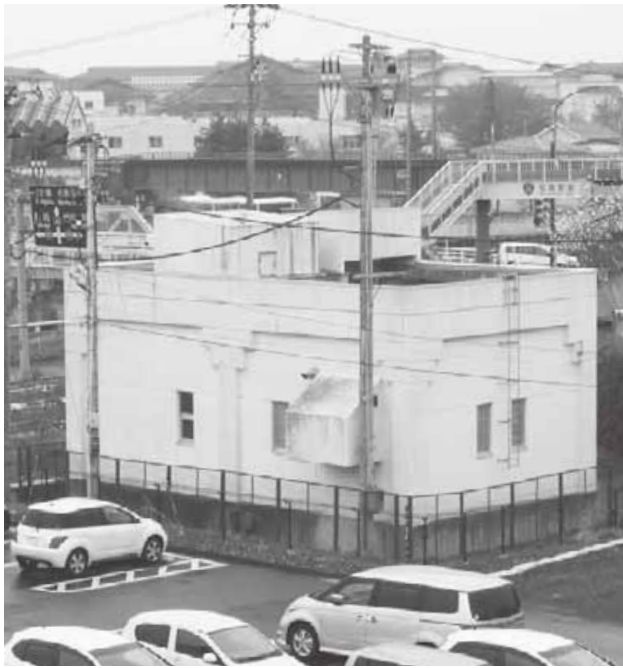
小梨屋排水区雨水ポンプ場
