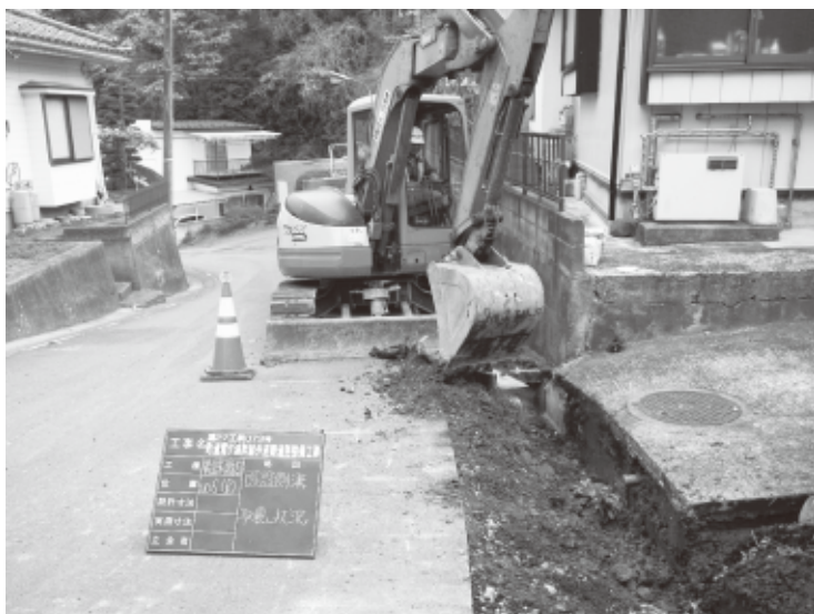
町道霞ヶ浦幹線外避難道路整備工事の様子
