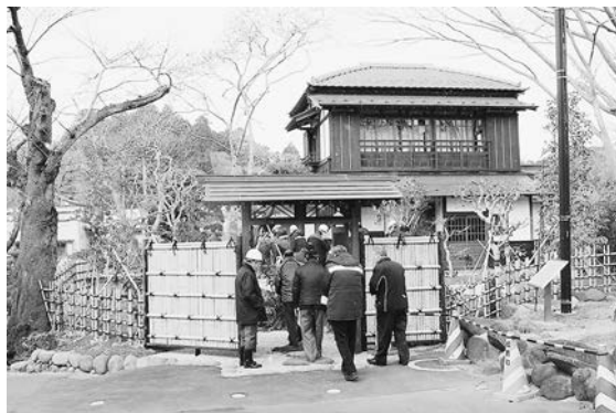
松島海岸公園避難施設
