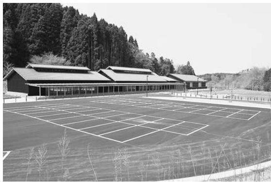
完成した石田沢防災センター
