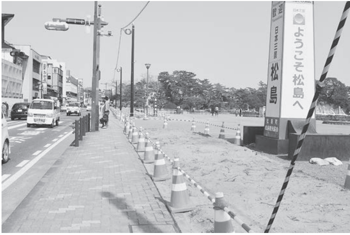
松島海岸下水道管の移設箇所
