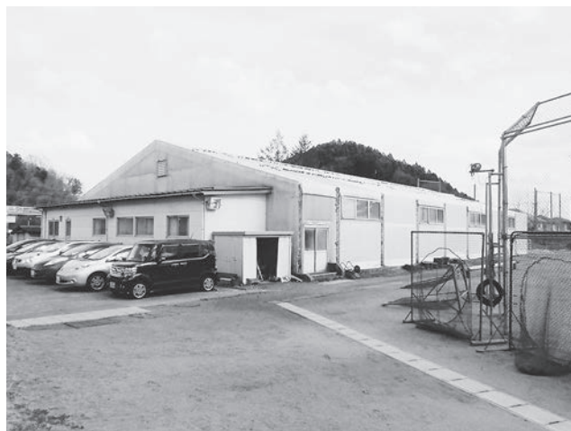
老朽化している松島中学校プール
