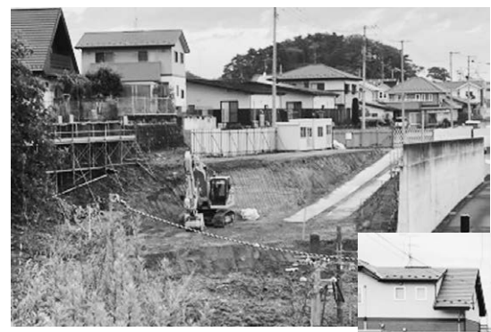
高城こ線橋工事
