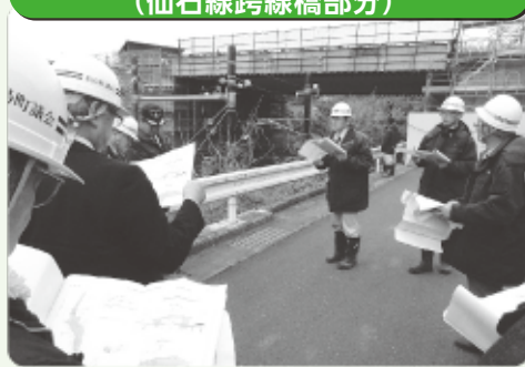
根廻磯崎線道路整備事業 (仙石線跨線橋部分)
