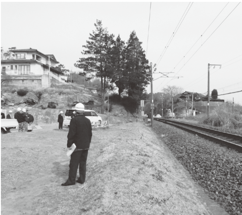
霞ヶ浦地区避難道路整備の状況
