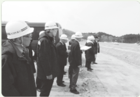
どんぐり太陽光発電所建設工事見学
