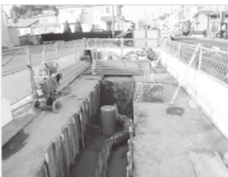
水道管布設工事
