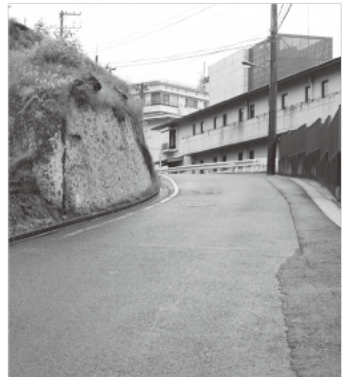
岩を削って道路が6mに拡幅される新富山付近
