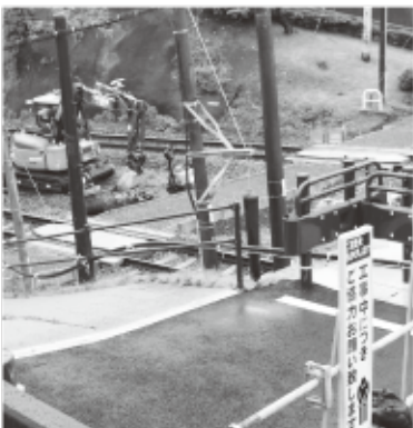
霞ヶ浦踏切付近の整備状況
