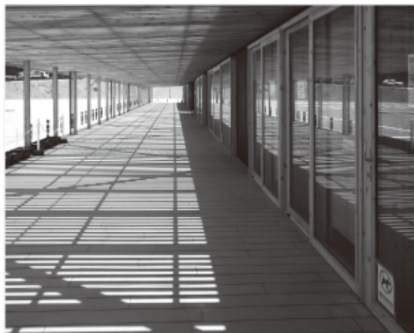
石田沢防災センター
