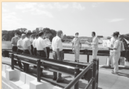
一級町道松島・磯崎線 (松島大橋) 橋梁外災害復旧工事
