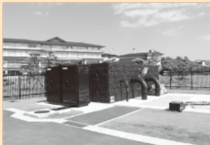
磯崎第二雨水ポンプ場復興事業
