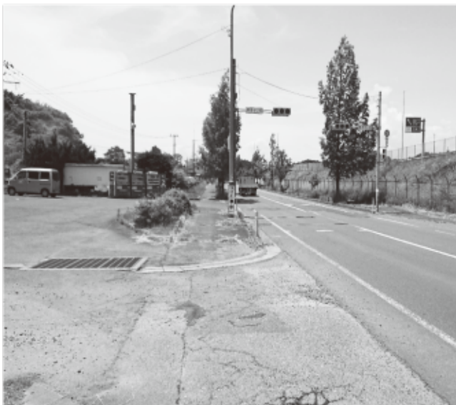
町道根廻・磯崎線と国道45号との交差点部
