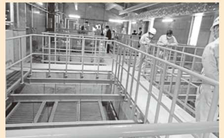
二子屋浄水場 松島町二子屋浄水場建設工事 (水道事業所)
