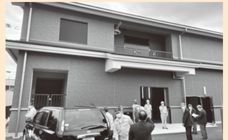
西柳雨水ポンプ場 西柳雨水ポンプ場の復興事業に係る 建設工事委託に関する協定(水道事業所)
