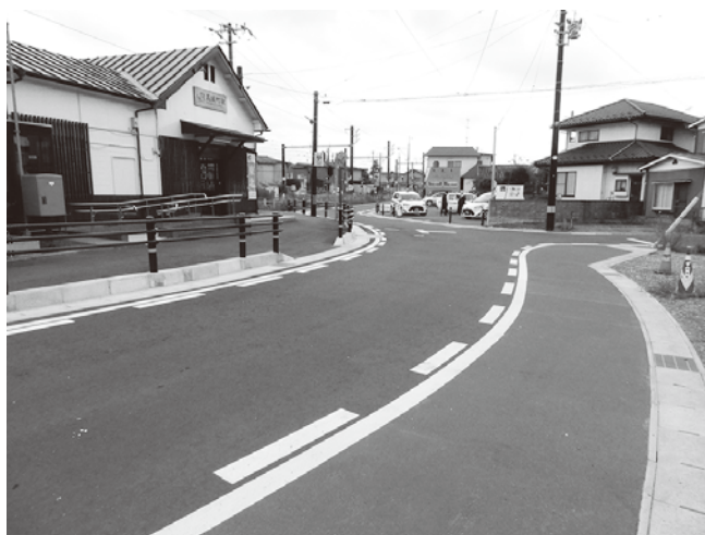
町道磯崎・高城町駅線（高城町駅前）
