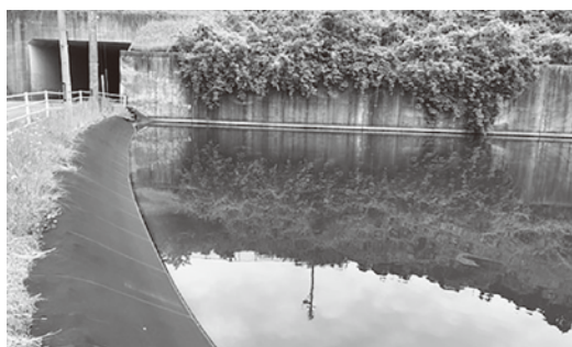
遮水シートを設置した溜池
