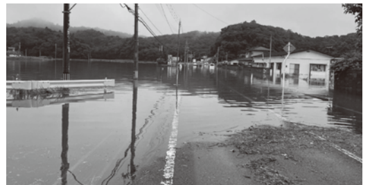
手樽交差点で冠水した様子
