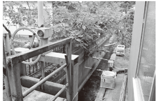
初原樋田地区の排水状況
