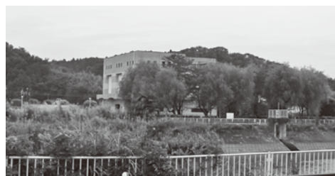
松島浄化センター
