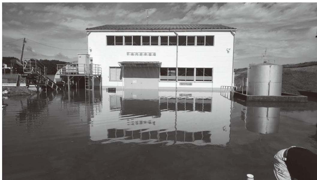
水没した不来内排水機場
