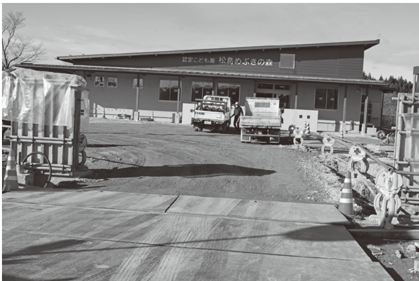
認定こども園まもなく完成（令和4年12月撮影）
