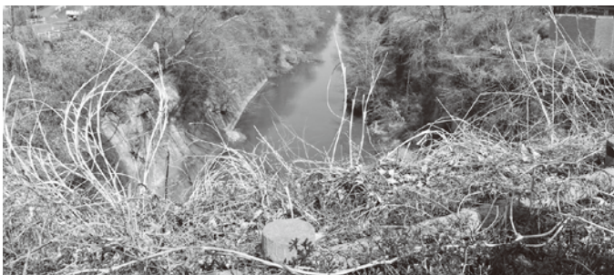
河川敷の雑木の状況を確認
