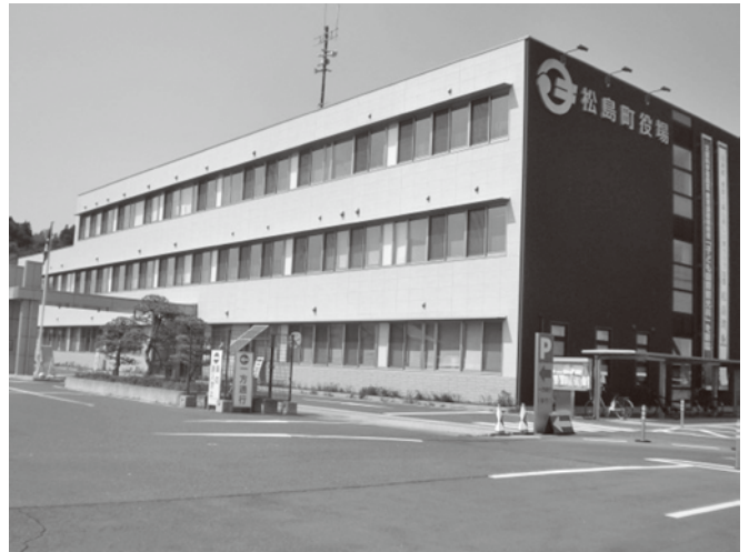
現庁舎の状況 (R5.4.4 撮影)
