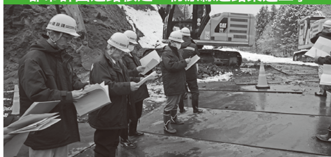
工事の進捗状況の確認
