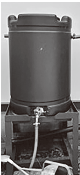
家庭用雨水タンク
