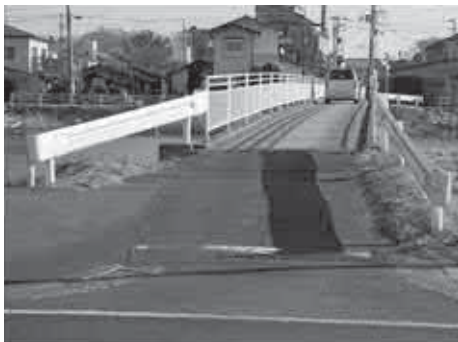
歩行者の安全確保が望まれる中橋
