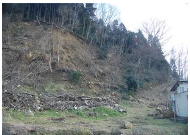
16. 愛宕山の崖崩れ
