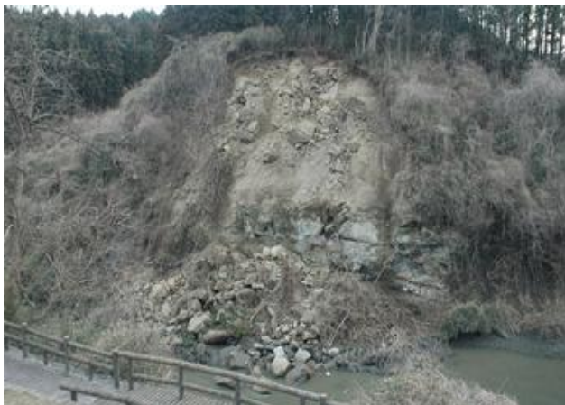
13. 明治潜穴穴尻付近の崖崩れ
