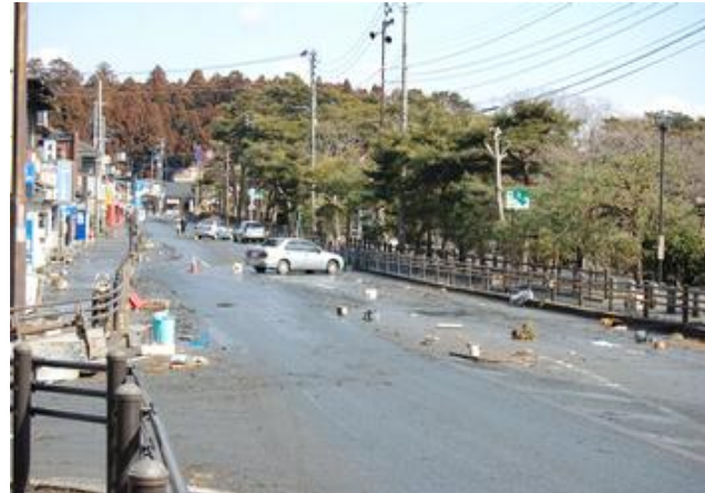
22. 津波が引いた後の国道45号
