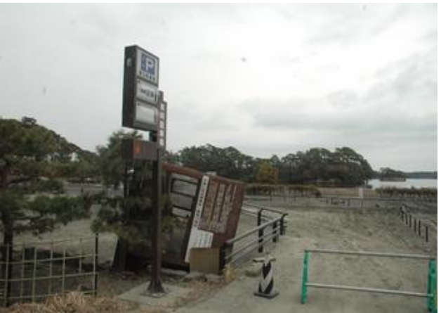
7. 津波で横転した管理棟（県営第5有料駐車場）
