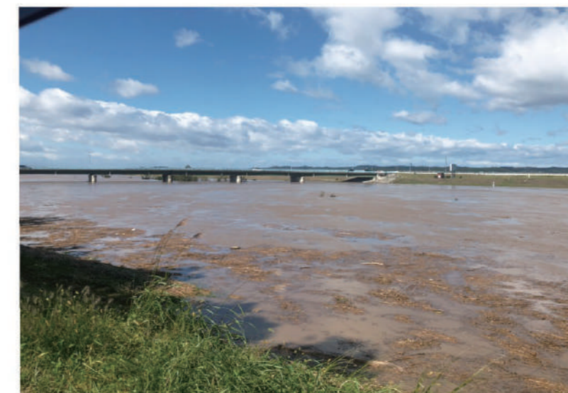
令和元年台風19号通過後の様子
