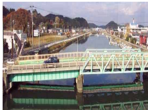
J R 仙石線跨線橋からみた高城川
