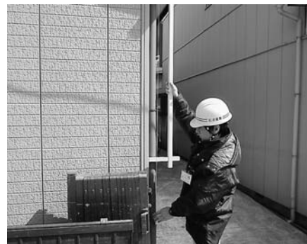
▲被害建物調査を支援するにかほ市の職員の方
