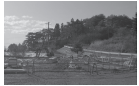
▲整備工事中西行戻しの松公園
