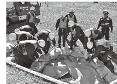
▲消防団による水防訓練。月の輪工法で堤防決壊防護措置を実施
