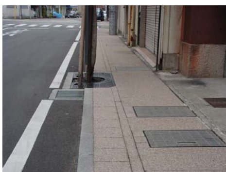
暗渠改修により歩行空間を確保した例
