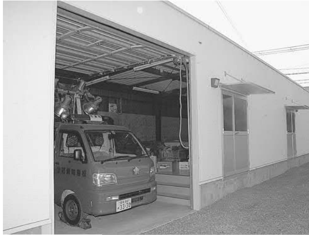
▲災害用資材等を保管する備蓄倉庫（高城）
