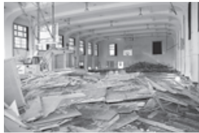
▲解体が進む松島中学校講堂
