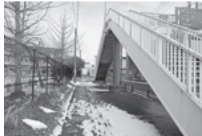
▲歩道が拡幅される第一小学校前歩道橋周辺
