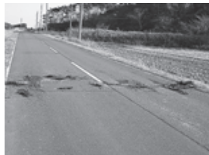
▲急ピッチで復旧作業が進められています
