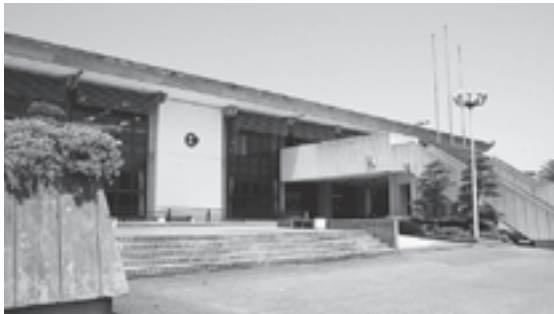
▲中央公民館の大規模改修を実施します
