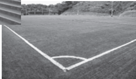
▲路盤が修復された人工芝グラウンド
