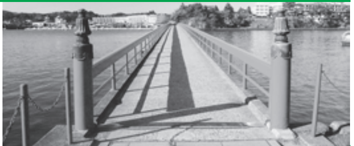
福浦橋を渡り、植物を見ながら散策を 福浦橋 ☎354-3457
