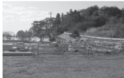
▲整備工事中の西行戻しの松公園
