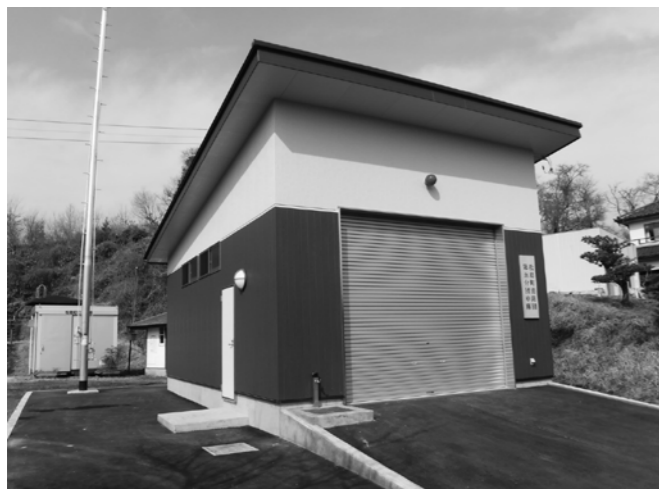
▲新しくなった消防車庫
