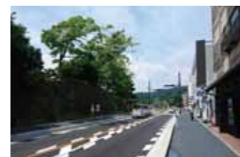
▲国道整備の推進【国道45号歩道拡幅】
