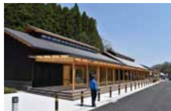
▲災害対策の推進【石田沢防災センター】
