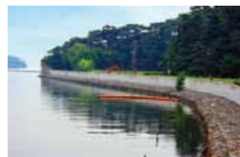
▲河川・港湾改修の促進【高城川護岸工事】
