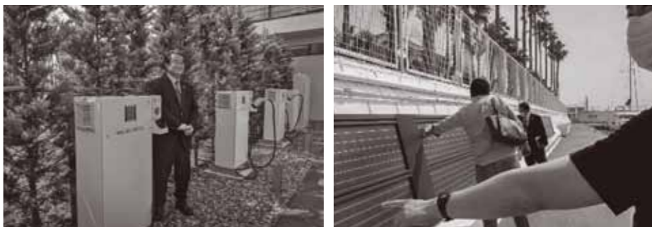
▲防波堤にある薄いフィルムの太陽光パネル ▲電気自動車の電気を施設の電力として活用できる装置を日本の宿泊施設で初めて導入した
