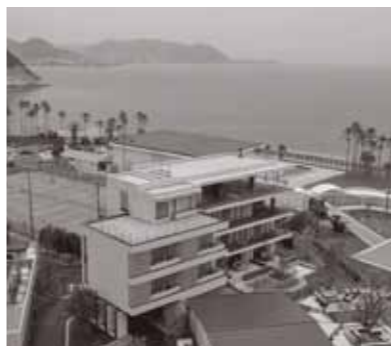
▲太陽光パネルが設置されたホテル
