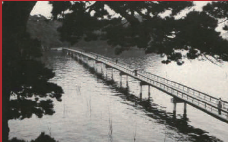
▲昭和8年に架設された木造の福浦橋 ※松島町誌第二版に掲載
