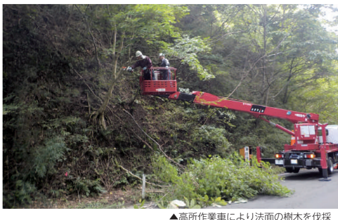
▲高所作業車により法面の樹木を伐採
